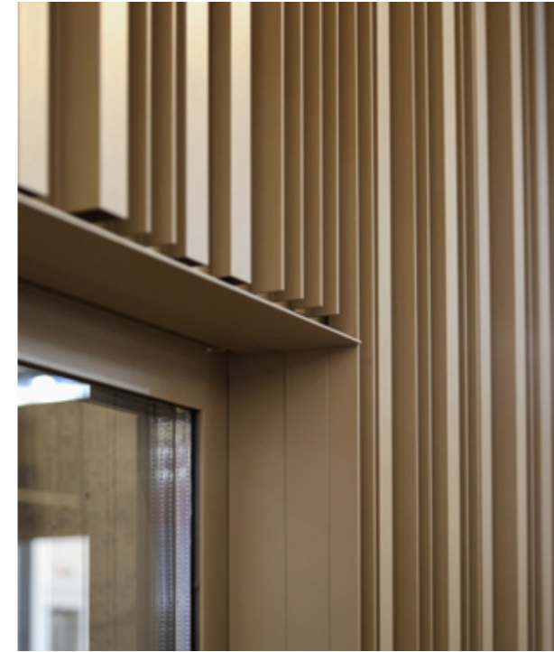
Profils de finition pour les ébrasements en phase avec la couleur, la structure et la qualité du bardage Linarte.
