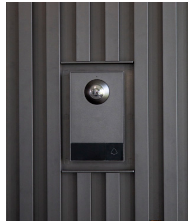
La vidéophonie est intégrée dans le bardage grâce à des modules spécialement conçus à cet effet, avec plaque aveugle dans la même finition que la façade.
